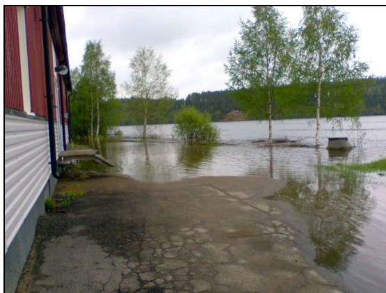
Figur 5. Översvämning vid avloppsreningsverk. (Foto: R. Jönsson)
